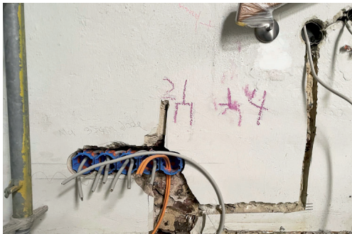
Es wurden 5 km Kabel verlegt.
